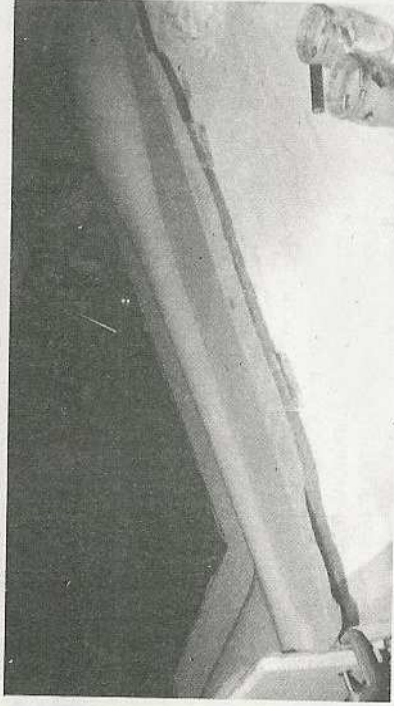
C'est reparti pour le deuxième demi-moule! Première opération, gel-coating, bien évidemment!
