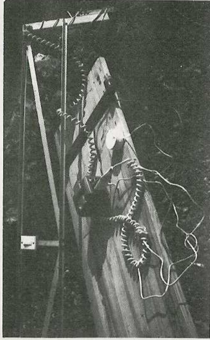
Autre alimentation pour faire chauffer le fil à découper le polystyrène : un transfo 220V/30V et un gradateur de lumière, simple et efficace.
